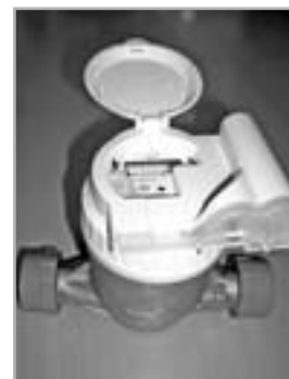
Die neuen Wasserzähler sind mit einem Sender ausgestattet
